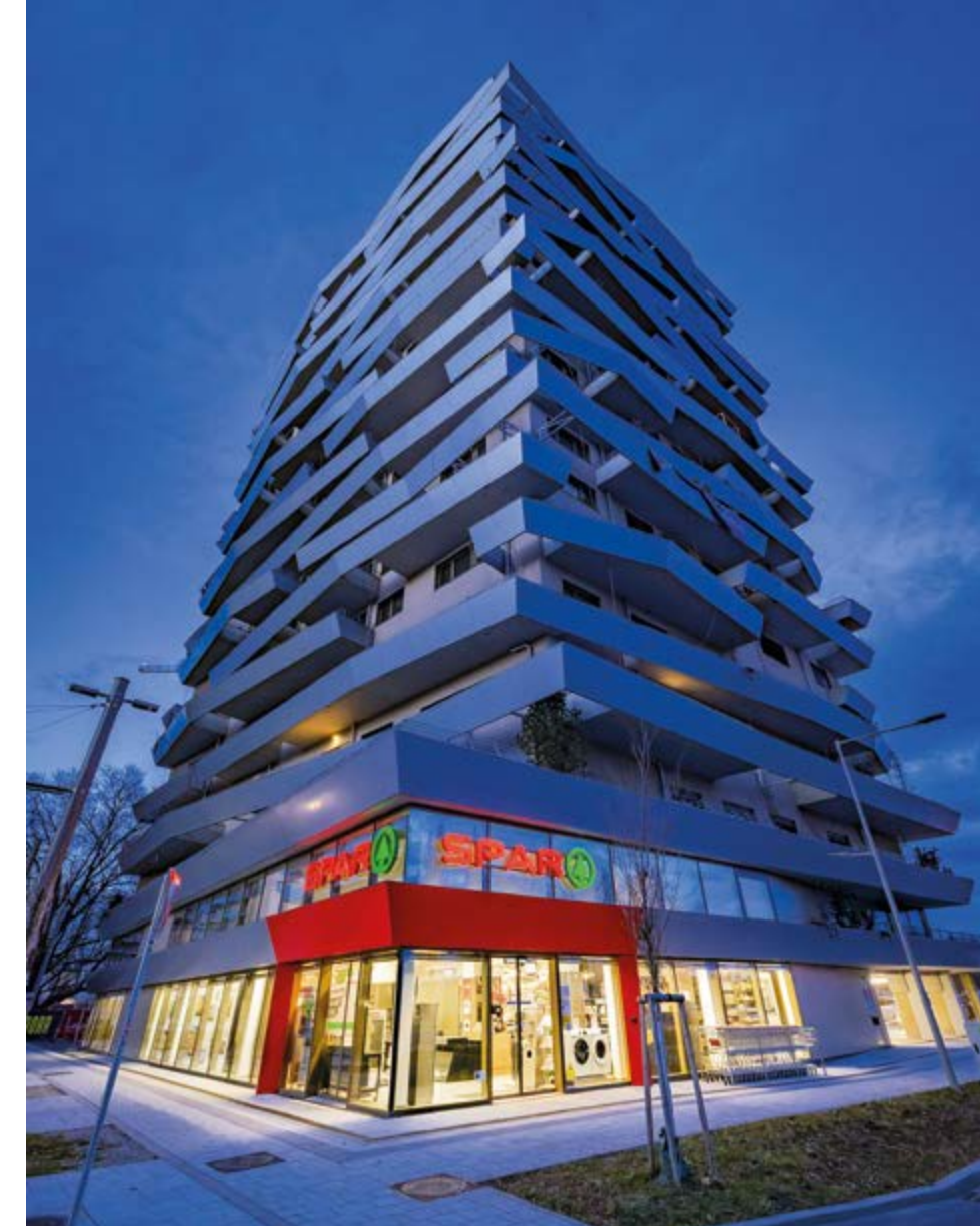
Im Green Tower in Graz wird Mixed Use gelebt: Von Wohnungen über öffentliche Flächen, einem Kindergarten, dem SPAR-Supermarkt bis hin zu Unternehmen und Arztpraxen.
